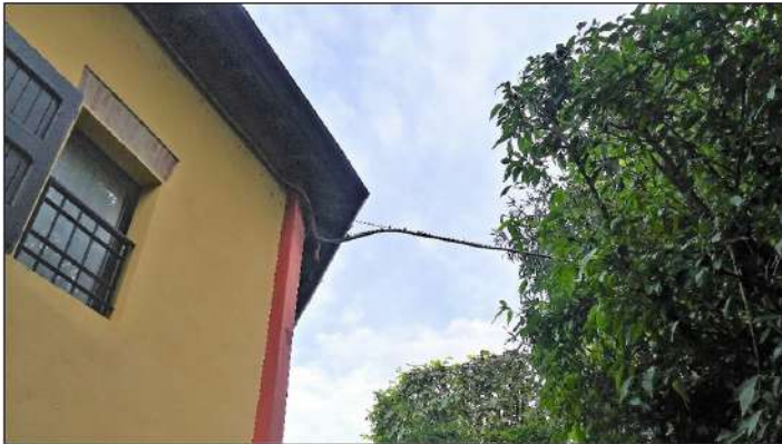
Fig. 3 Via di accesso di Ghiri nella soffitta di una abitazione del territorio modenese
